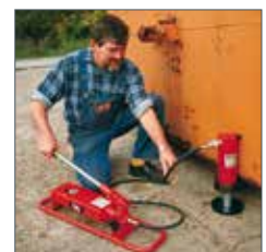
Anheben eines Containers mit Hydraulikzylinder YS-23/160, Hubklaue AYS-23 und Kolbenplatte AYS-232 sowie Handpumpe HPS-2/2 mit Bodenrahmen.
